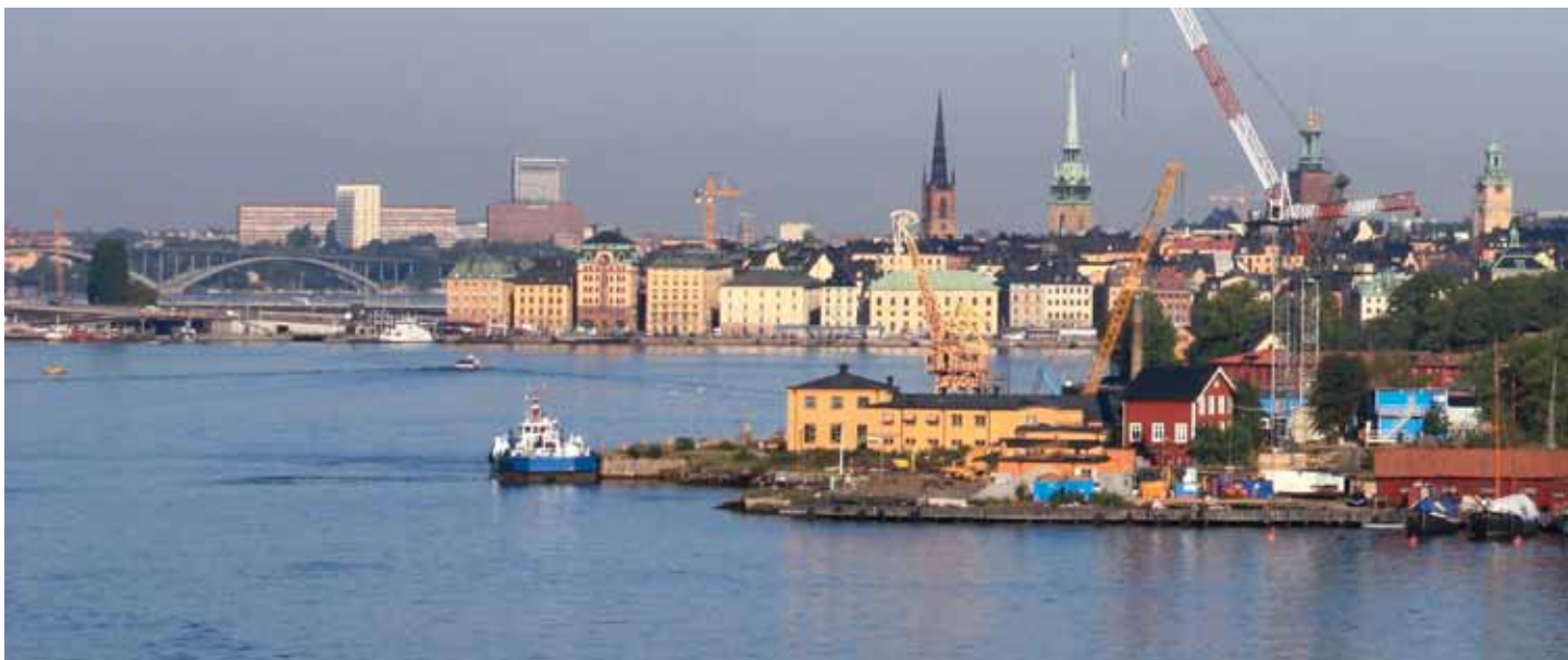
På Beckholmen genomförs ett av Sveriges största miljösaneringsprojekt.
