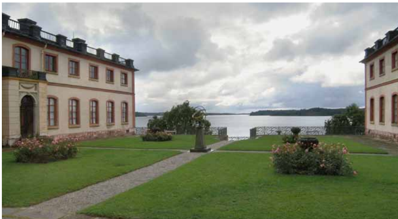
Tullgarns slott genomgår omfattande renoveringsarbeten.
