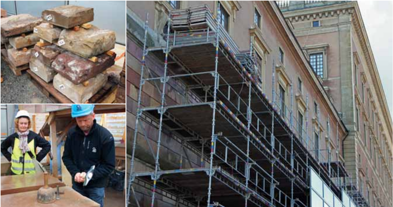
Första etappen har inletts av det omfattande fasadrenoveringsprojektet vid Stockholms slott.
